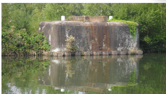
Bunker entlang Zuid Willemsvaart
