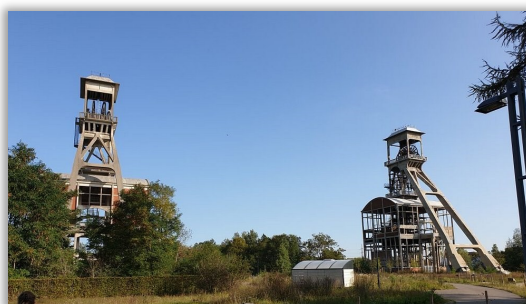
Schachttürme Bergwerk Eisden
